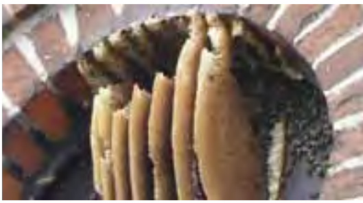
Dieses Volk fand keine geeignete Höhle. Das Blindfenster schützt nur notdürftig vor Regen und auch nicht vor Angriffen von Krähen.
